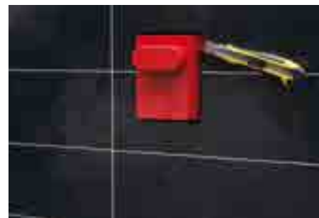
3. Отрезать монтажный короб вровень с облицовочной плиткой.
