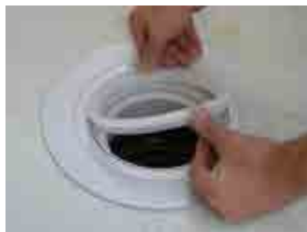
9. Убедиться в правильности установки прозрачного пластикового кольца
