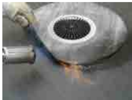
3. Приварить полимербитумное полотно воронки
