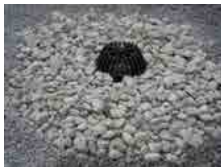
12. Засыпать гравием остальную поверхность кровли
