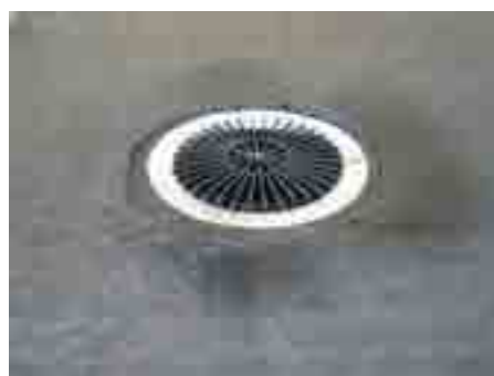
5. Так должна выглядеть воронка после укладки гидроизоляции
