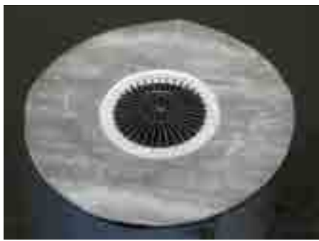
2. Нанести праймер, наклеить 1-й слой гидроизоляции
