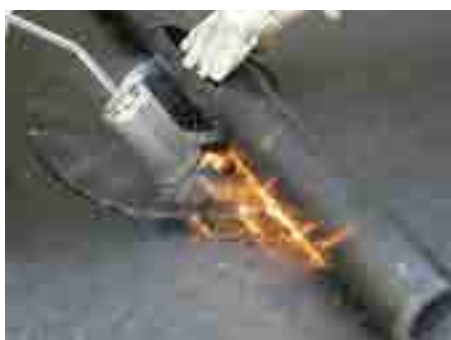
4. Наклеить 2-й слой гидроизоляции (до обжимного фланца)
